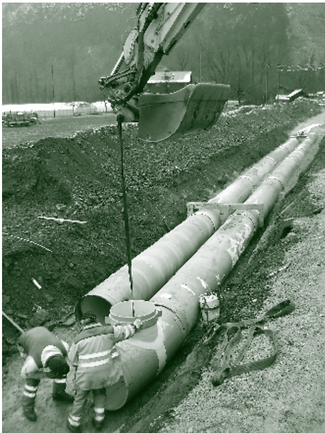
8.12.2008: Bau der Stapelleitung für Deponieabwasser
