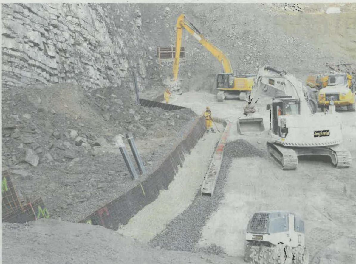
Mit den laufenden Bauarbeiten wird die Randabdichtung der Deponie Eielen gegen die Felswand bis 15 Meter erhöht.
