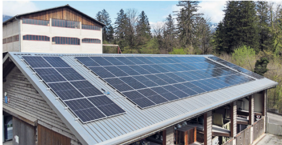
Die neu erstellte Photovoltaikanlage auf dem Sammelstellen-Gebäude.
