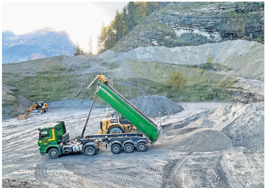
Aktuell werden die angelieferten Schlacken direkt auf der Deponie gekippt und dann eingebaut. Dies soll sich jedoch ändern. FOTO: ZAKU
