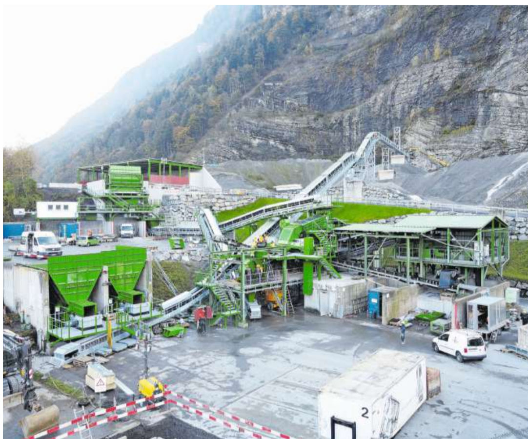
Die Arbeiten zum Umbau der Aufbereitungsanlage sind fortgeschritten.
