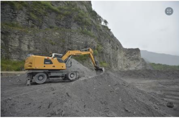
Die Deponie Eielen wird seit 34 Jahren mit Schlacke verfüllt.
