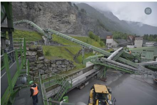
Blick auf die eindruckliche Schlackenaufbereitungsanlage.
