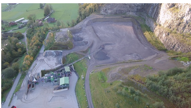
Foto 3: Zwischen Felswand und Deponie wird die Randabdichtung erhöht
