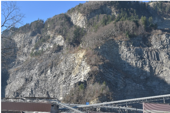
Foto 2: Mit dem Abbau der Felsnase zwischen Steinbruch und Deponie und der Erstellung von Bermen wird die Arbeitssicherheit erhöht
