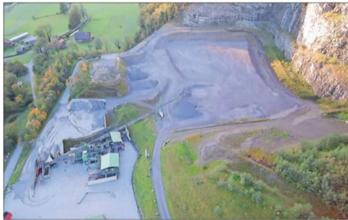
Zwischen der Felswand und der Deponie wird die Randabdichtung erhöht. FOTOS: ZVG
