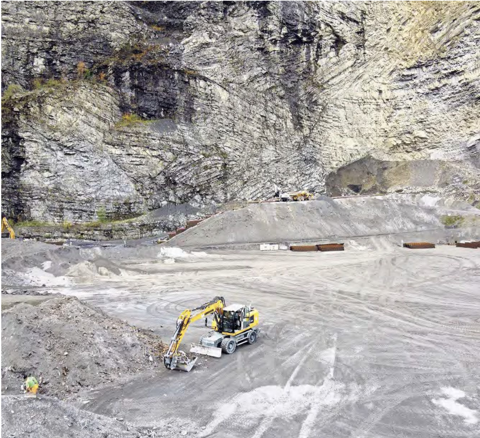
Die Randabdichtung der Deponie Eielen gegen die Felswand wird aktuell um rund 25 Meter erhöht. FOTO: ZVG
